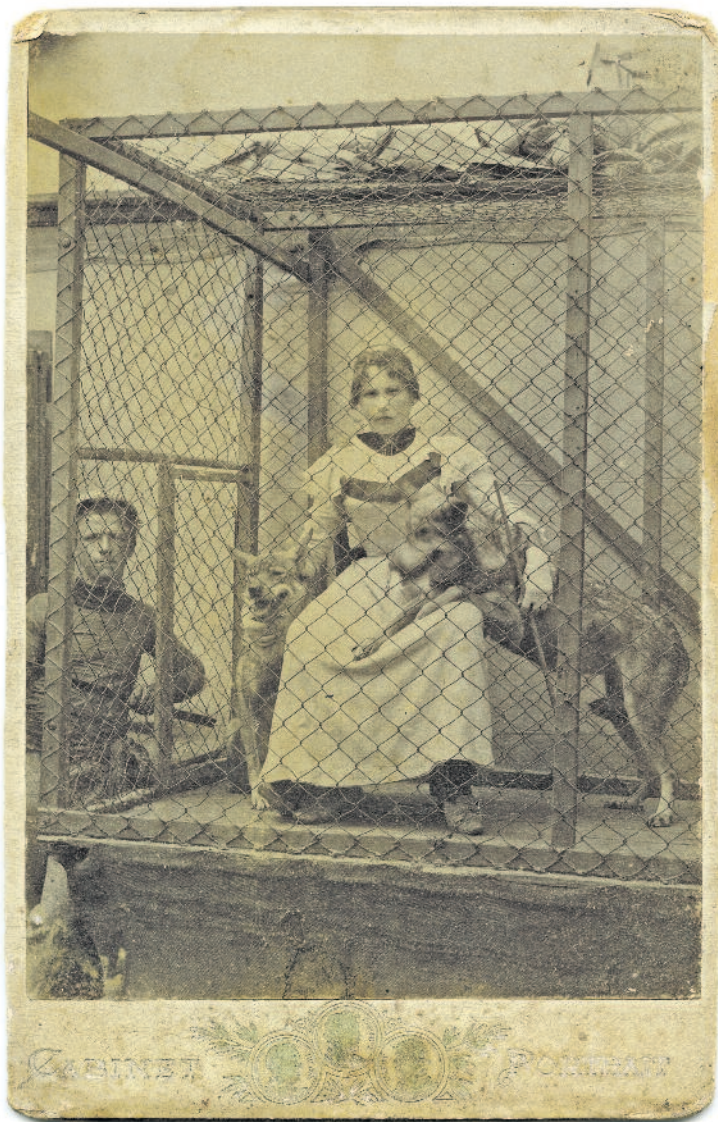
Emma Strobl (geb. Mayerott), Wolfsdompteurin, um 1900. Foto Firma Avi, Wels
